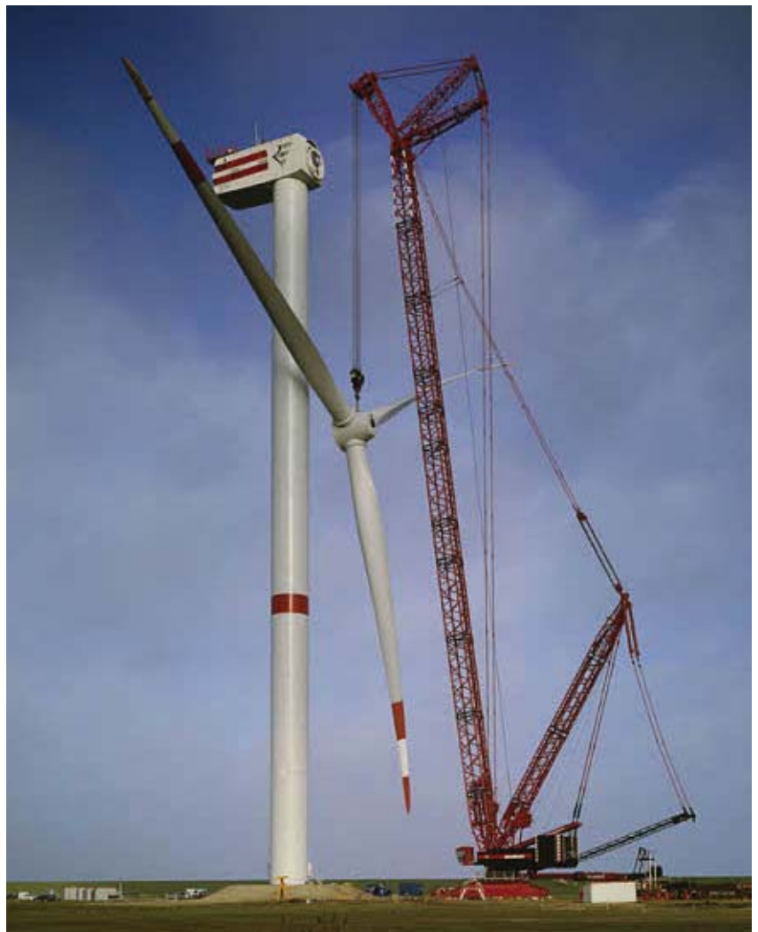
Kuva 13. Tuulivoimalan pystytys tela-alustaisella nosturilla (Liebherr 2012b).
